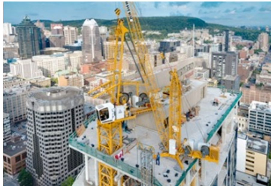
Kren Derik untuk kerja-kerja perombakan kren menara
