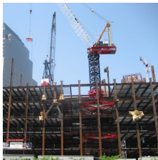
Rajah 4.8 Pemasangan kren jenis tapak mandiri dalaman ( www.dcm.milgromandassociates.com )
