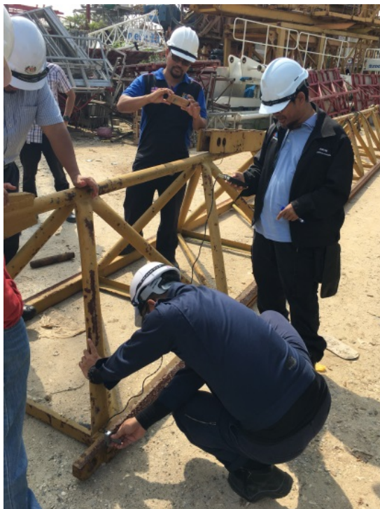
Rajah 9.27 Kaedah Metal Magnetic Memory (MMM) sedang dilakukan oleh operator pada komponen kren menara
