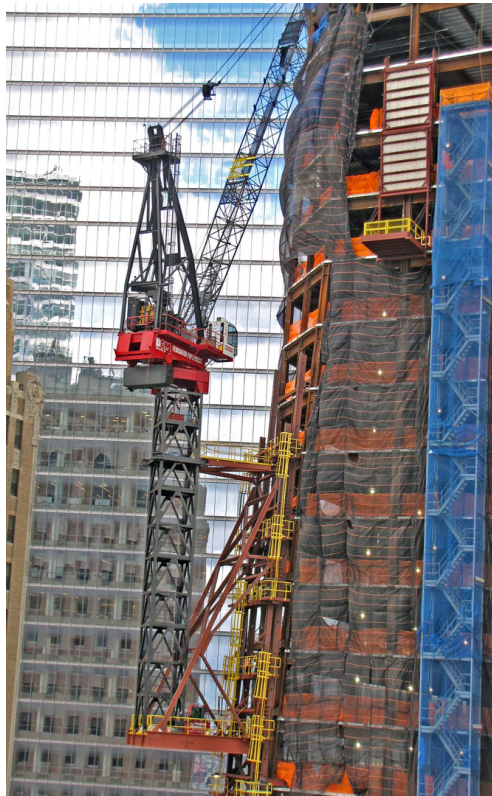
Rajah 1.1 Pemasangan kren dengan tapak mandiri luaran ( www.dcm.milgromandassociates.com )
