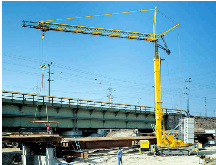
Rajah 1.7 Kren menara meninggi sendiri yang digunakan di tapak bina
