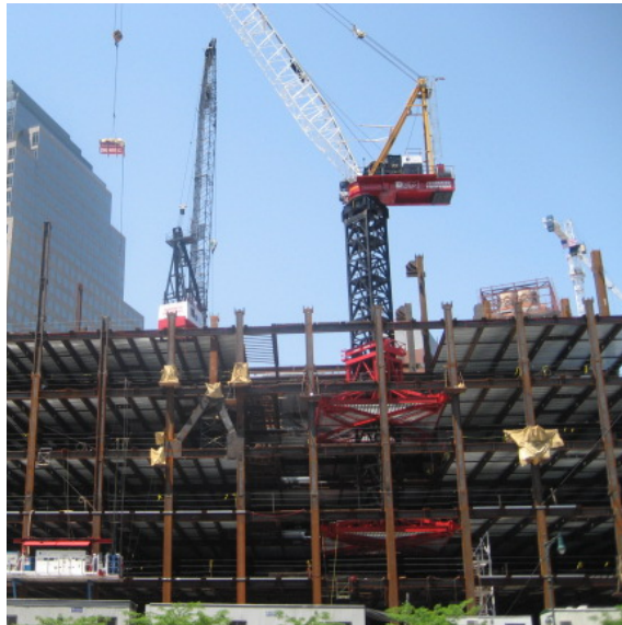
Rajah 1.2 Pemasangan kren dengan tapak meninggi dalaman ( www.dcm.milgromandassociates.com )
