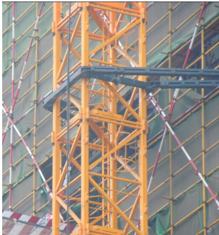
Rajah 10.5 Kren menara yang diikat dengan pengikat dinding
