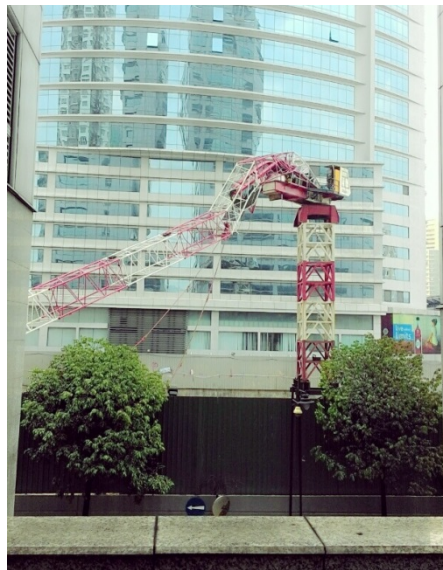
Rajah 10.19 Kemalangan kren menara jenis luffing di Bangsar
