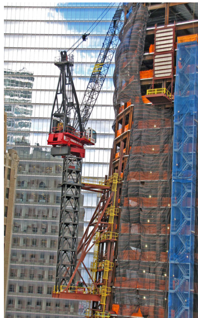
Rajah 2.11 Pemasangan kren dengan tapak meninggi luar ( External climbing crane ) ( www.dcm.milgromandassociates.com )
