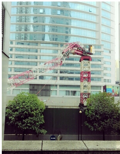
Rajah 9.8 Kemalangan kren menara jenis luffing di Bangsar
