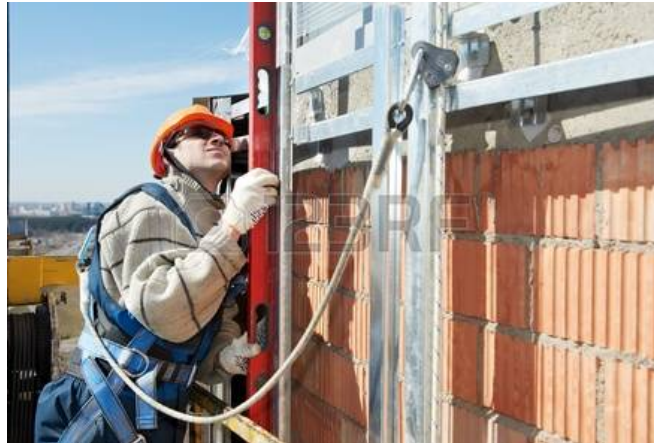
Rajah 8.10 Cara penggunaan dan memanjat dengan betul ( https://www.123rf.com/photo_13536201_worker-builder-at-facade-construction-works.html )
