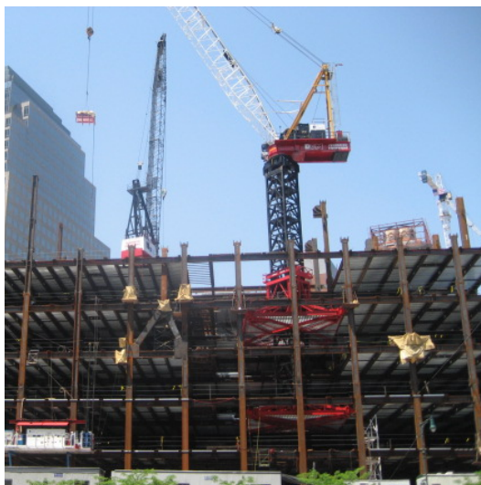
Rajah 2.14 Pemasangan kren dengan tapak meninggi dalam ( Internal climbing crane ) ( www.dcm.milgromandassociates.com )
