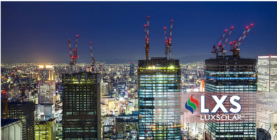
Rajah 7.4 Lampu amaran pesawat pada kren menara
