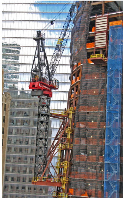
Rajah 2.13 Pemasangan kren dengan tapak meninggi luar ( External climbing crane ) ( www.dcm.milgromandassociates.com )
