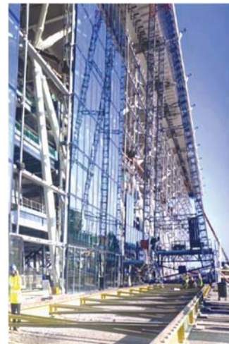
Gantry digunakan untuk memasang panel kaca condong
