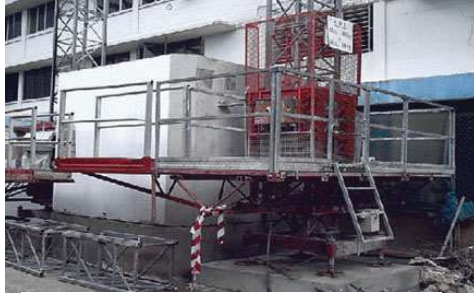
Pemasangan lif shaft
