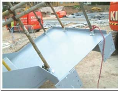
pemegang tangan sementara dipasang di aras tanah (lubang yang sama kemudian digunakan untuk pemegang tangan tetap)
