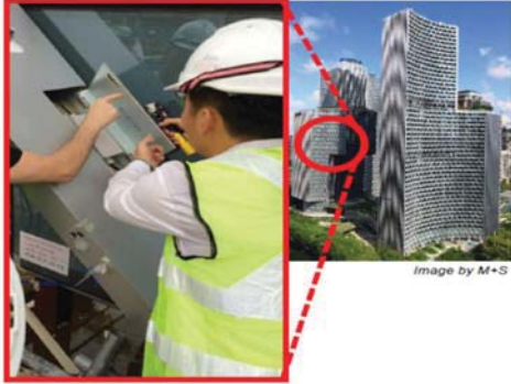
Lekapan lampu fasad harus mudah diakses untuk penyelenggaraan
