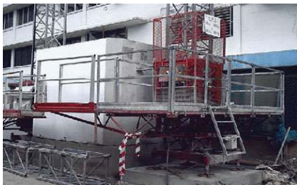
Pemasangan lif shaft
