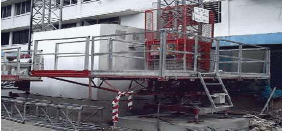
Pemasangan lif shaft
