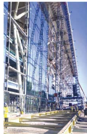
Gantry digunakan untuk memasang panel kaca condong
