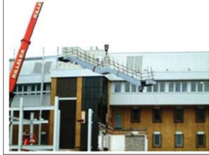
Tangga dengan Perlindungan tepi diangkat ke dalam Struktur Bingkai Keluli
