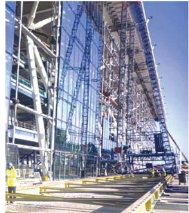
Gantri digunakan untuk memasang panel kaca condong
