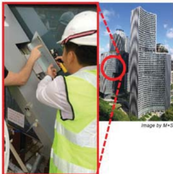
Lekapan lampu fasad harus mudah diakses untuk penyelenggaraan
