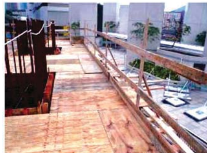
Platform kerja yang disediakan untuk kerja pemasangan keluli pada ketinggian (di atas 2m)
