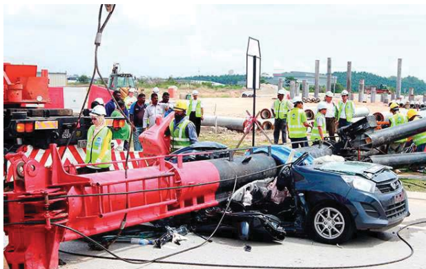
Gambar fail menunjukkan pekerja buruh binaan mengangkat mesin cerucuk yang menghempas sebuah kereta sekaligus membunuh pasangan terlibat pada 5 Nov di Klang. - Gambar Bernama
