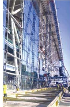
Gantry digunakan untuk memasang panel kaca condong
