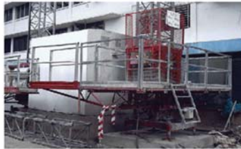
Pemasangan lif shaft
