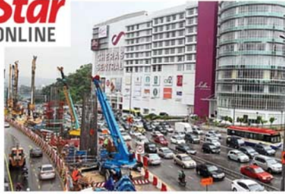
Mimpi ngeri: Pemandu di sepanjang Lebuhraya Cheras-Kajang melangkah masuk ke East-West Link dan Jalan Cheras yang secara mendadak diperketatkan untuk pembinaan MRT. -
