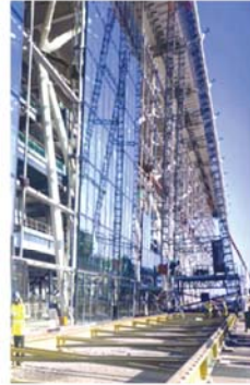
Gantry digunakan untuk memasang panel kaca condong
