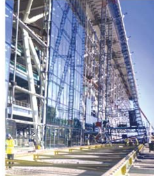
Gantri digunakan untuk memasang panel kaca condong
