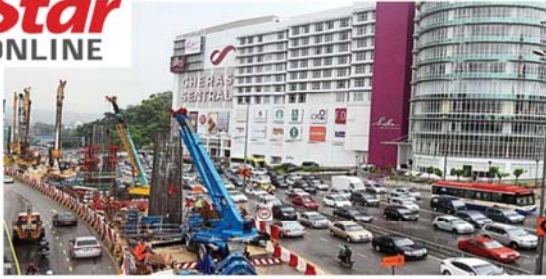
Mimpi ngeri: Pemandu di sepanjang Lebuhraya Cheras-Kajang melangkah masuk ke East-West Link dan Jalan Cheras yang secara mendadak diperketatkan untuk pembinaan MRT. -
