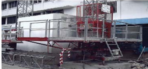
Pemasangan lif shaft
