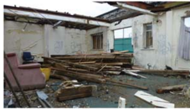
Perobohan telah dilakukan dengan tangan dengan pekerja memanjat ke bumbung tanpa mengambil kira keselamatan. Imej: HSE
