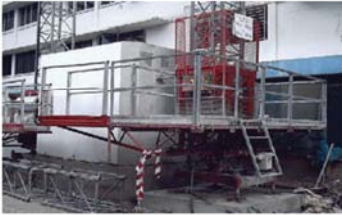
Pemasangan lif shaft
