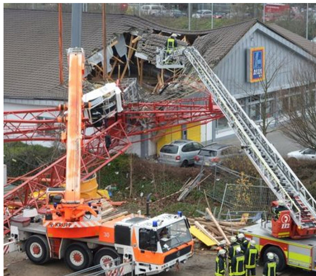
Rajah 2.33 Kemalangan kren menara yang runtuh di pasaraya Aldi di Homburg, Jerman ( www.cbc.ca )
