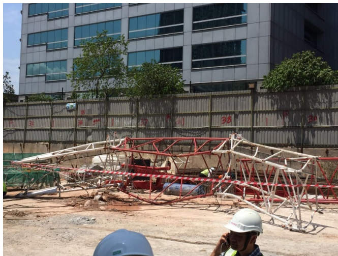
Rajah 4.9 Rangka kren yang telah dirungkai di tapak pembinaan
