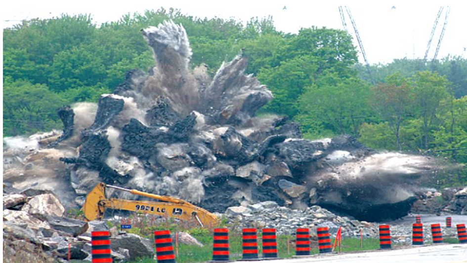
Kerja letupan batu di tapak pembinaan (JKPP, 2007)
