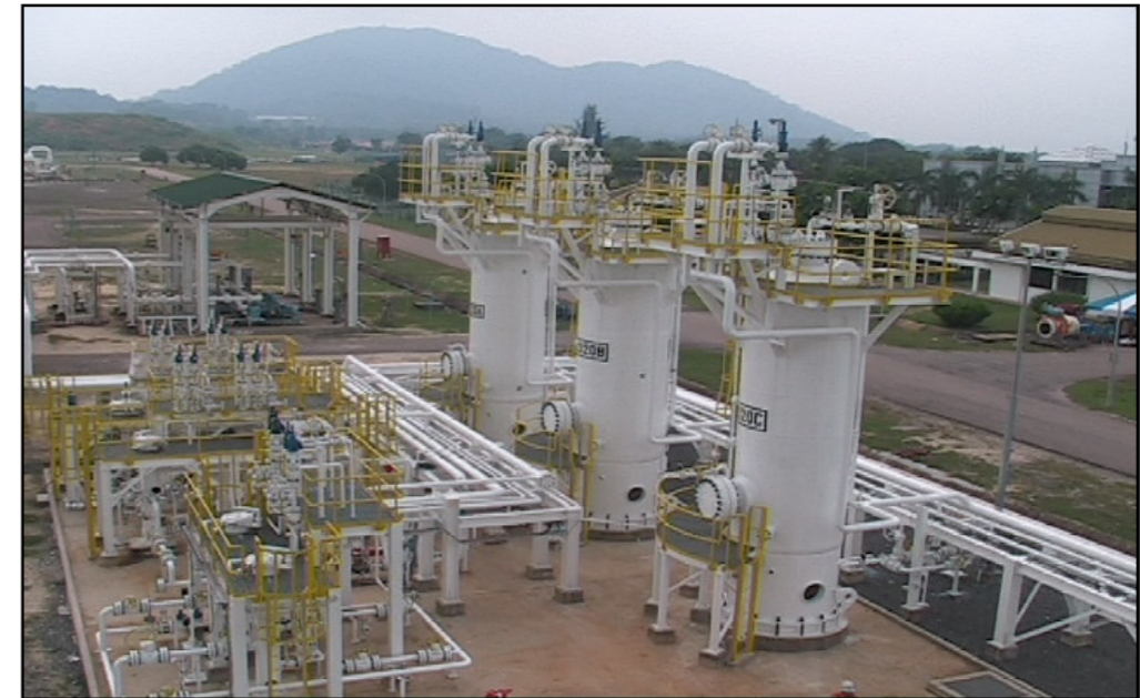
Rajah 7 Contoh sistem penyingkiran merkuri di sebuah fasiliti daratan
