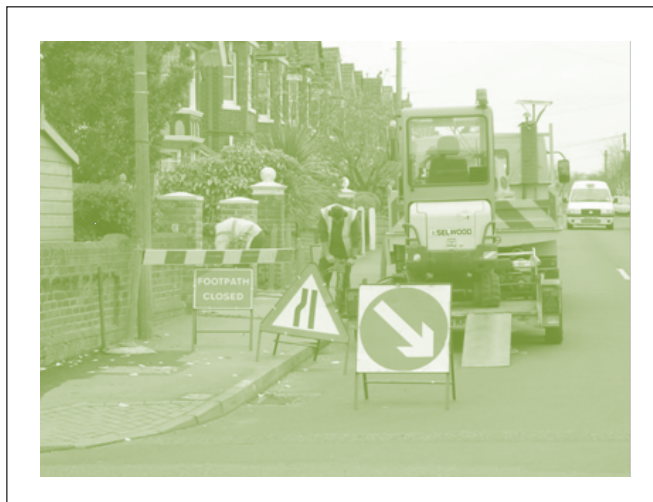
Rajah 17. Jika bekerja di atas atau berdekatan dengan jalan raya atau mana-mana tempat yang lalu lintas kenderaan awam boleh membahayakan orang yang sedang bekerja, kawasan kerja hendaklah dihadang serta tanda dan lampu amaran yang sesuai hendaklah dipasang untuk mengarahkan lalu lintas agar menjauhi kawasan kerja tersebut.
